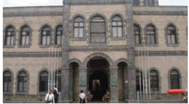
صورة (٣) واجهة مبنى المتحف الحربي-صنعاء
